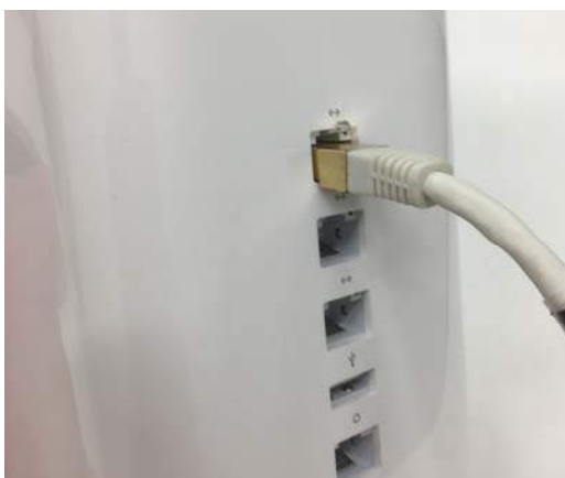
[Wifi Access Point LAN port]
